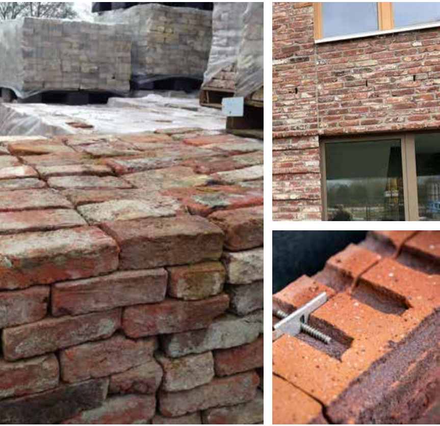
Bij een duurzame keuze voor een steen kan bijvoorbeeld gekozen worden voor hergebruik of goede demontabiliteit.
