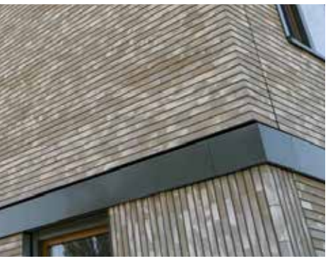
Afwijkend materiaal / metselverband begane grondverdieping
