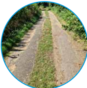
Oprit Boxbergerweg 79: karrenspoor
