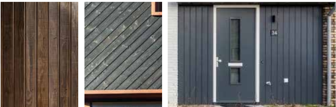
Naast baksteen zijn hier ook panelen toegestaan in de gevels, bijvoorbeeld van hout of gerecycled kunststof.
