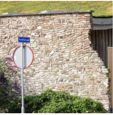
Hergebruik materialen, hier als aanleiding voor speciaal metselverband
