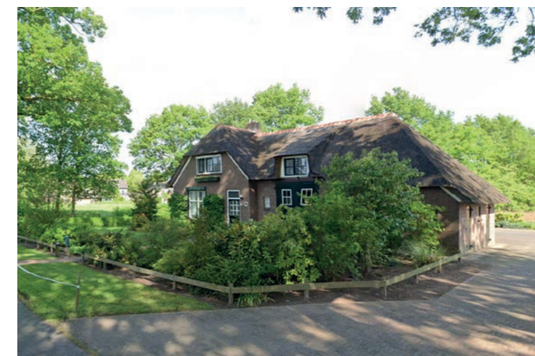
Erfbebouwing aan de Oerdijk
