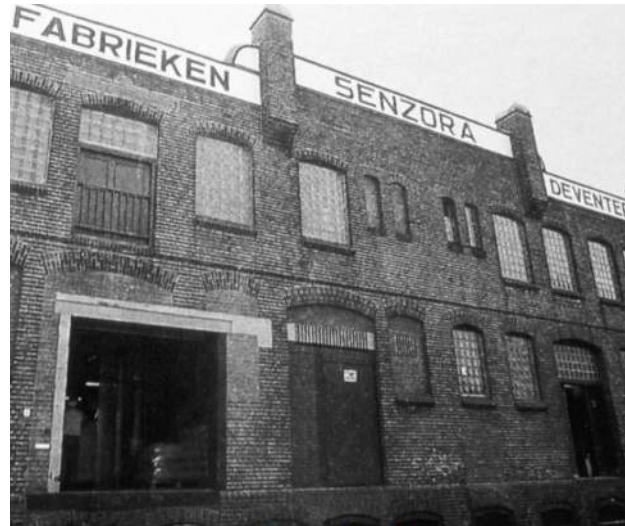
Senzoragebouw - noord gevel
