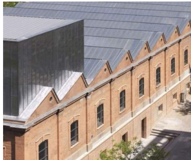
Entrees tekenen zich af in de gevel en zijn direct herkenbaar
