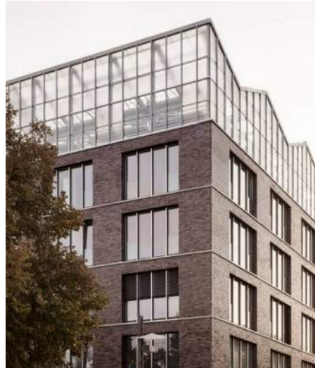
Glazen opbouw als verwijzing naar industriële architectuur
