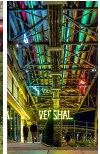
Verlichting gekoppeld aan brug
