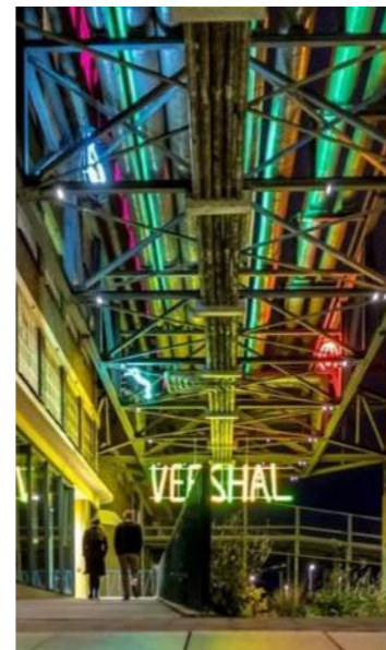
Verlichting gekoppeld aan brug
