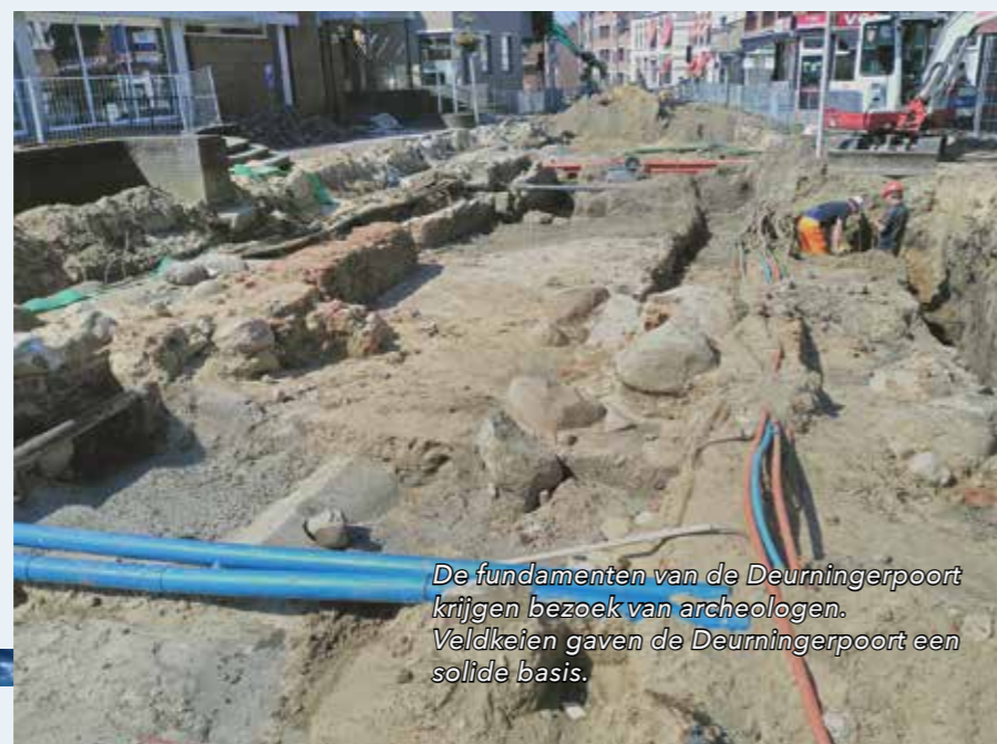
De weg open om rioleringen en leidingen te vernieuwen. Op de achtergrond de stokoude Plechelmuskerk.
