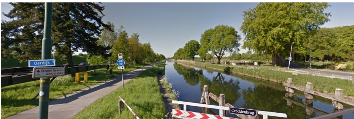
Foto 2.3 | Overijssels kanaal vanaf Oerdijk in zuidelijke richting
