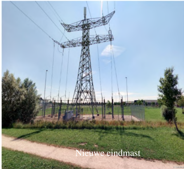
Figuur 1.12 | Voorbeeld van een eindmast met kabelovergang (opstijgpunt voor kabel)
