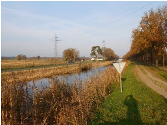
Foto 2.1 | Mast 19 en berm Overijssels Kanaal – N348
