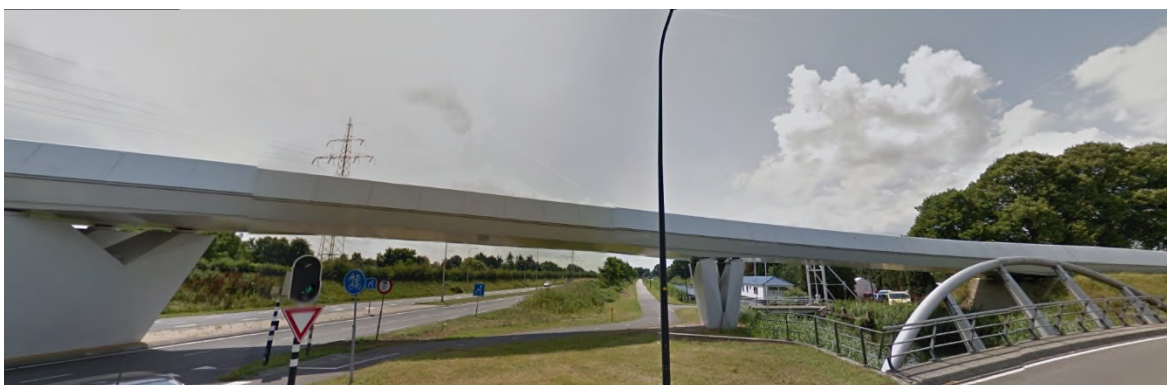
Foto 2.5 | Berm N348-Overijsselskanaal vanaf Nico Bolkesteinlaan in zuidelijke richting
