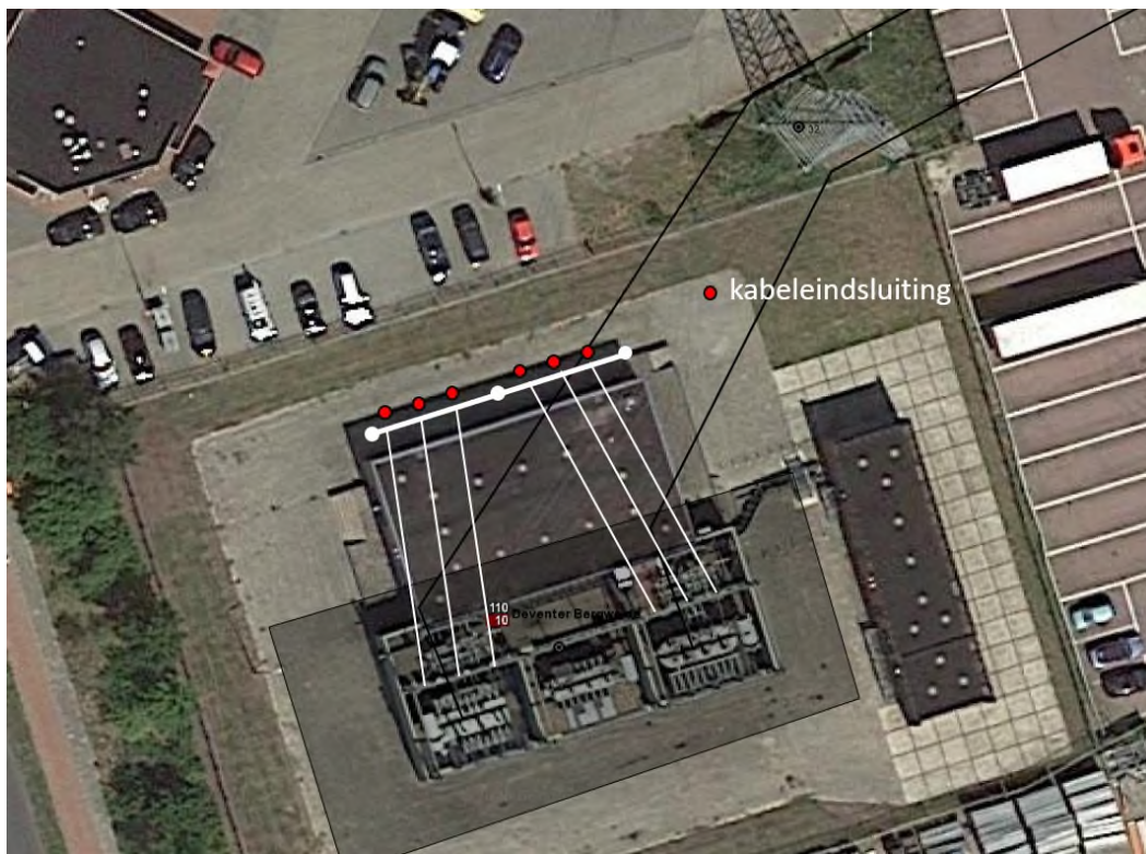
Figuur 1.9 | Station Bergweide met portaal.
