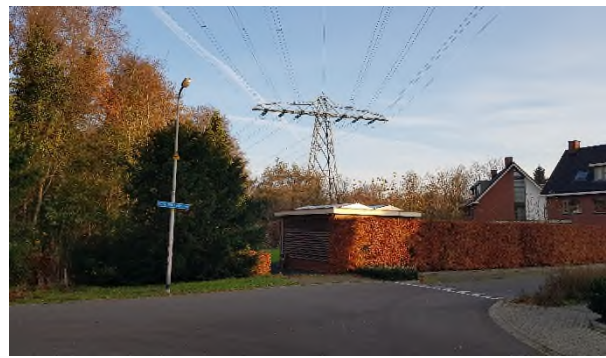
Foto 1.9 | Mast 74 gezien vanaf groenstrook Vossebeltweg
