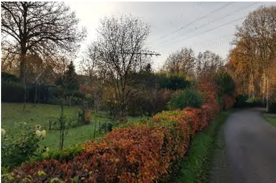
Foto 1.8 | Mast 74 in tuin A.Houtweg 10, vanaf T-splitsing
