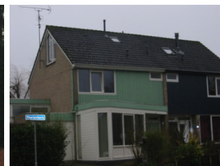
Bijbehorend bouwwerk op voorerf aan openbare weg
