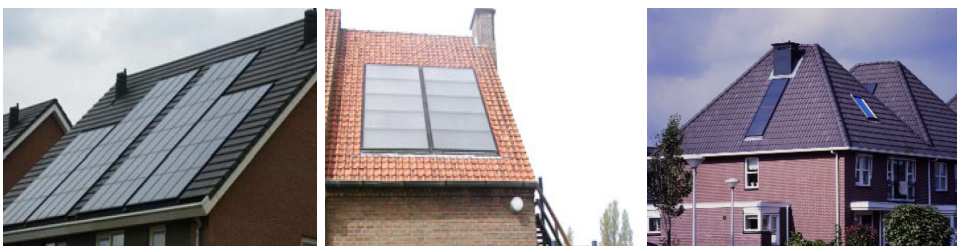
Diverse voorbeelden van plaatsing van zonnecollectoren in het dakvlak
