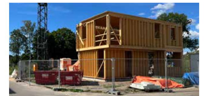
Houtbouw in de Tuinen van Zandweerd
