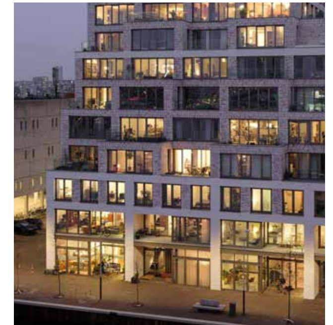
De Bocht, Cruquius - Amsterdam, 3 laagse stadswoningen aan de straat met daarboven appartementen (bron: Levs Architecten)
