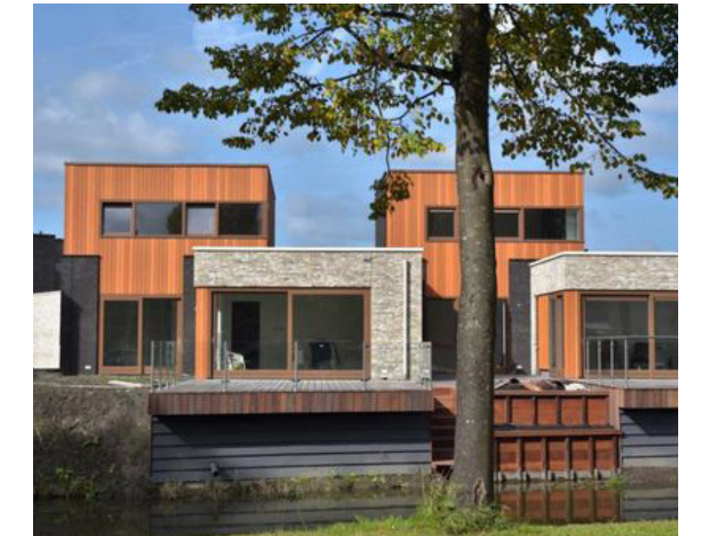
houten gevelbekleding en metselwerk
