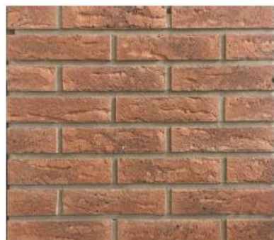
Metselwerk - Oranje FW5
