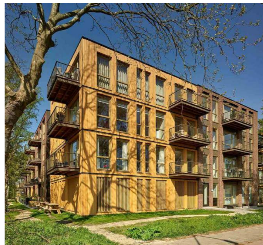
combinatie van hout en metselwerk
