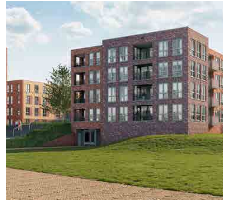
stenen appartementengebouw met inpandige balkons
