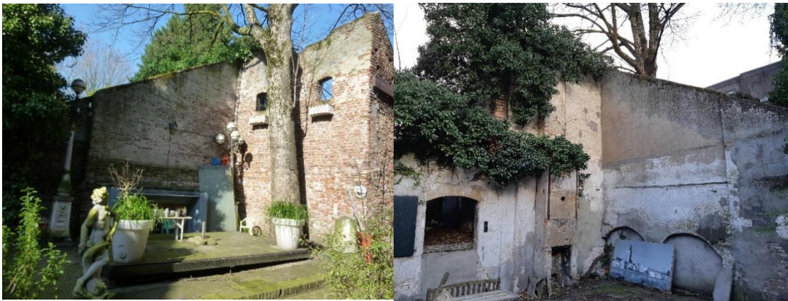
Figuur 13: Foto's oude muren Grote Overstraat 29-33-35
