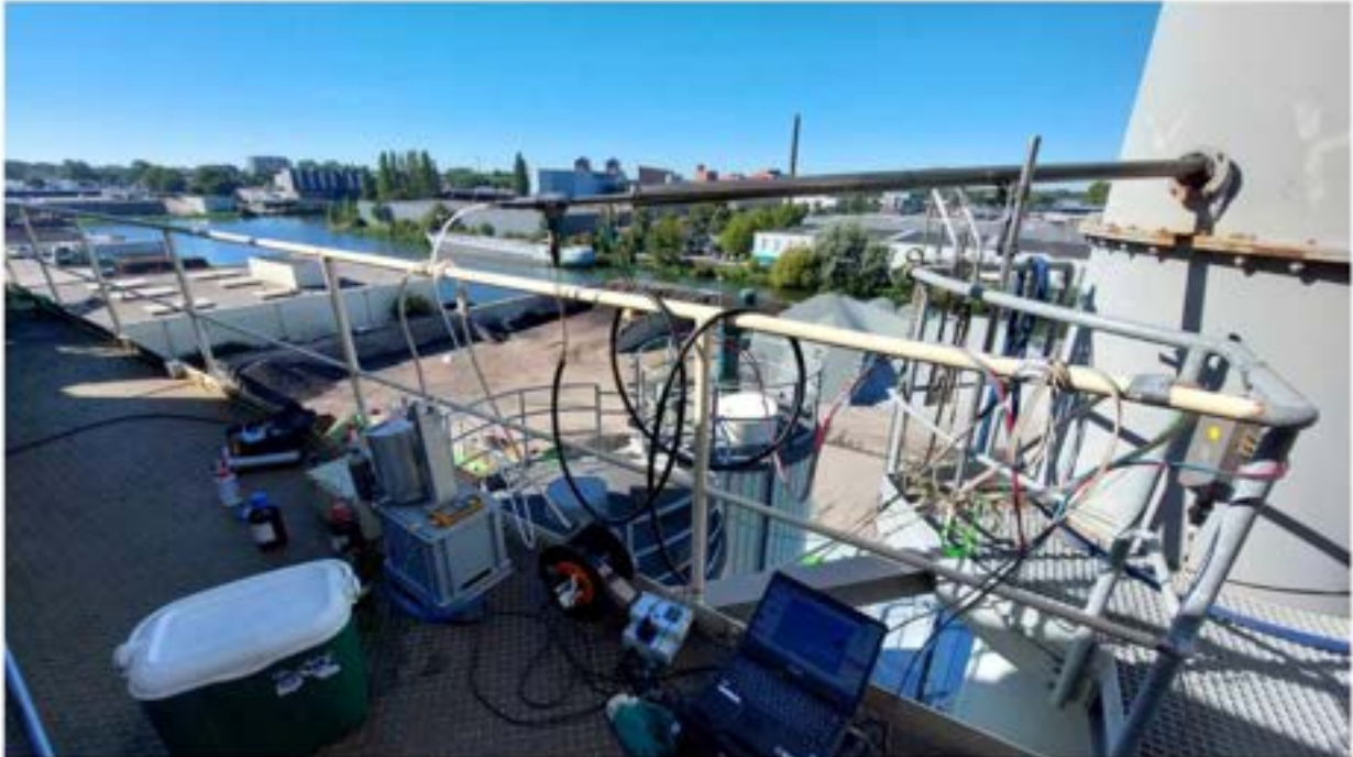
Foto 1c: Meetvlak centrale schoorsteen AsfaltNU Deventer, d.d. 5 september 2023.
