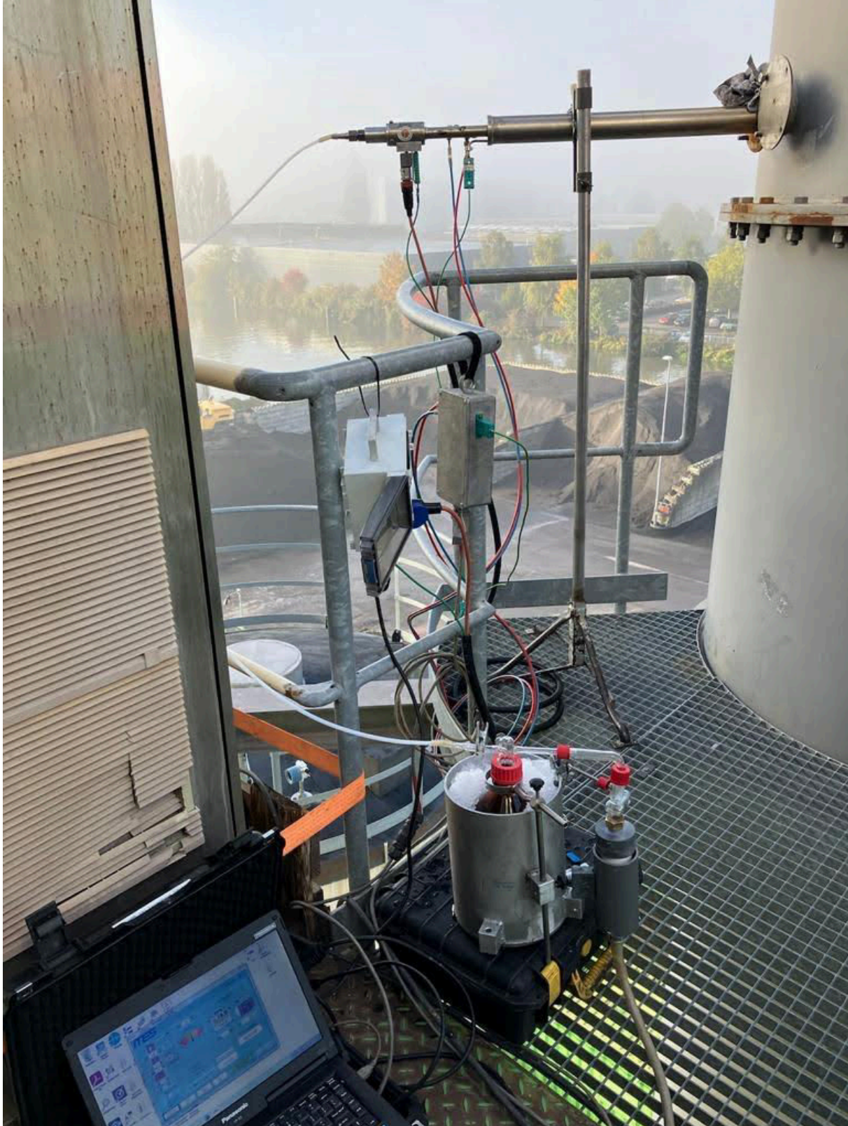
Foto 1c: Meetvlak centrale schoorsteen AND te Deventer, d.d. 18 oktober 2022.
