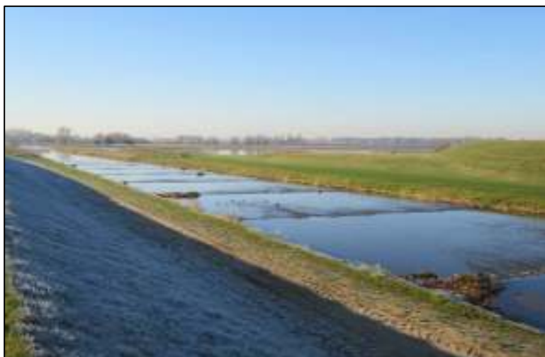
Figuur 64. De vistrap in de schipbeek die uitmond in de rivier de IJssel. Bron: Matthé Wind
