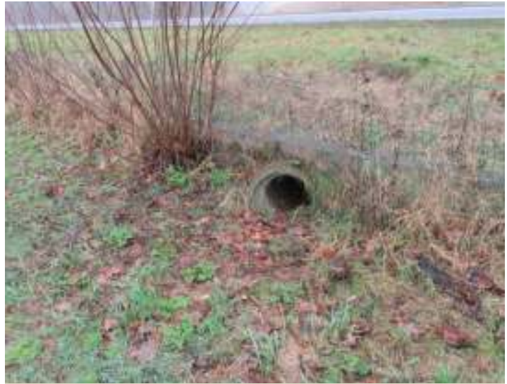
Figuur 26. De faunapassage met in de achtergrond de N348 Bron: Matthé Wind
