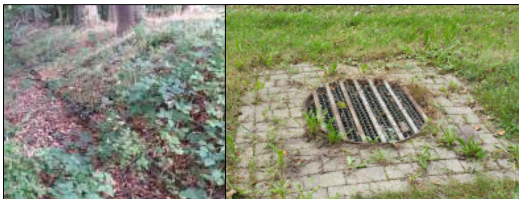
Figuur 16. Links: De kapotte en overwoekerde geleiding van passage 5. Rechts: De lichtput voor de amfibieënpassage. Bron: Matthé Wind
