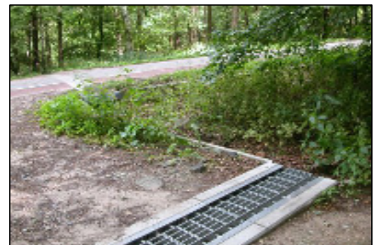
Figuur 6. Een goot met een vierkant profiel voor amfibieën en ander klein wild. Geleiding van polymeerbeton, en een rooster met spijlen <8 mm. Bron: www.ravon.nl
