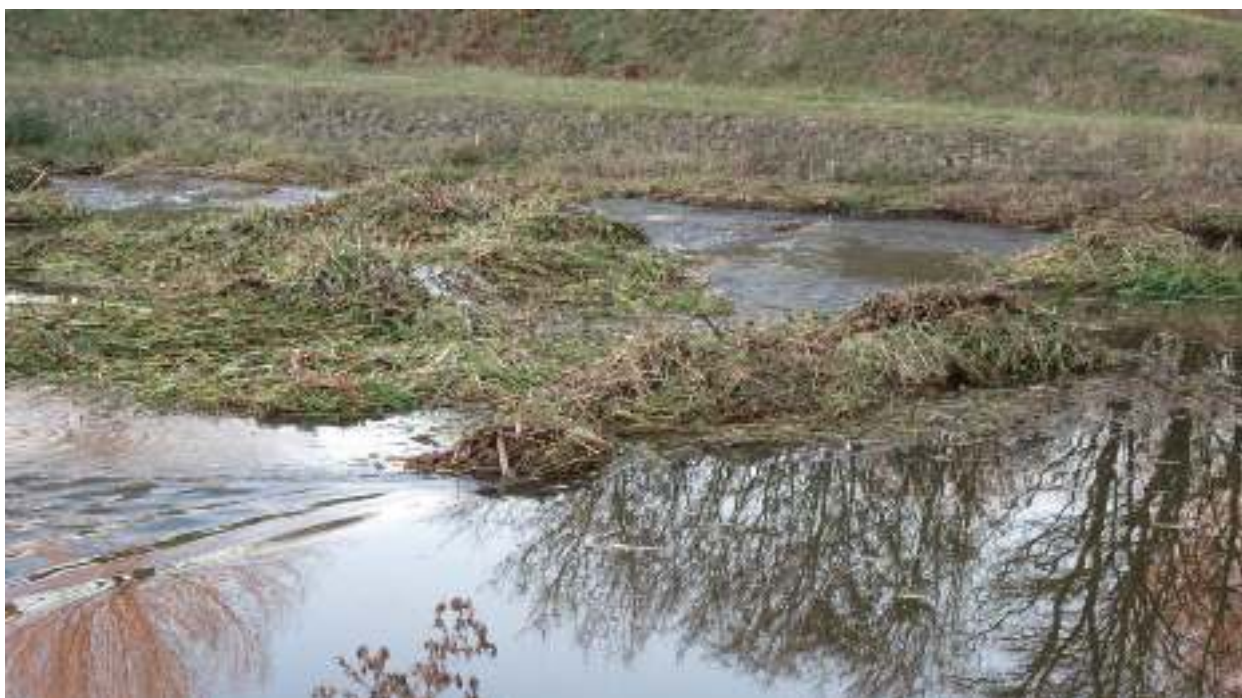
Figuur 68. Plantenresten in de vistrap belemmeren de doorgang. Bron: Matthé Wind
