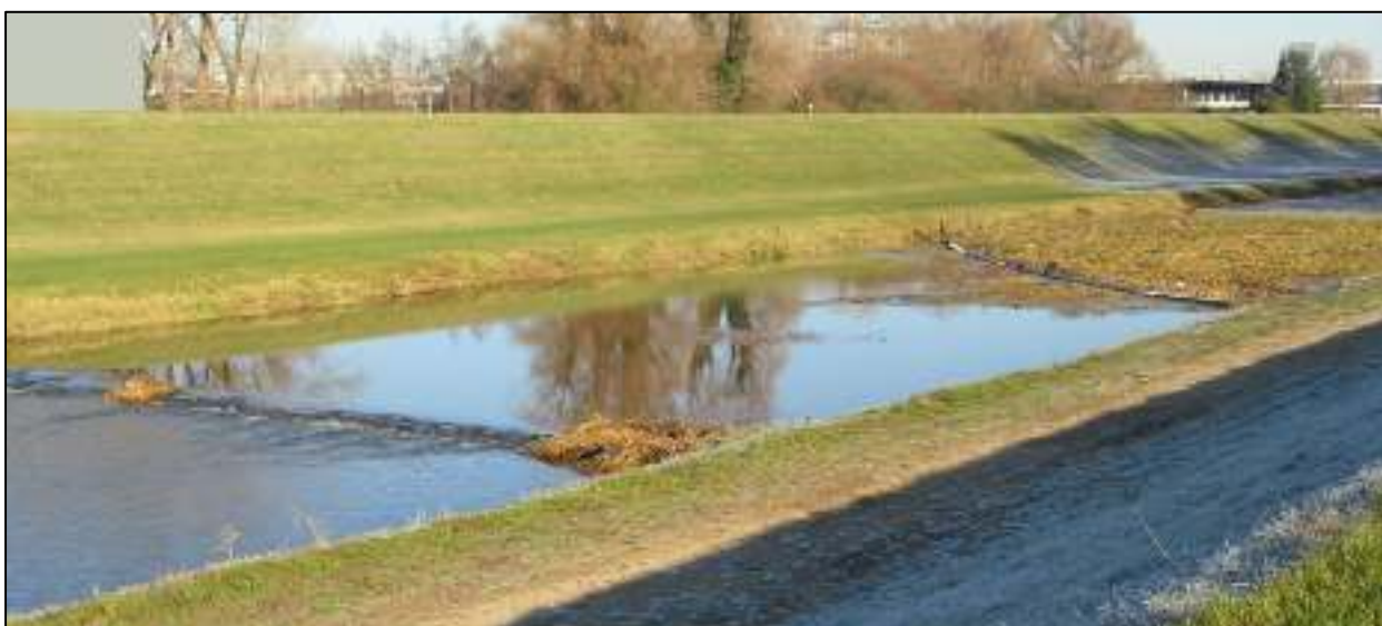
Figuur 65. De vistrap met de vuilvanger in de schipbeek nabij de rivier de IJssel. Bron: Matthé Wind
