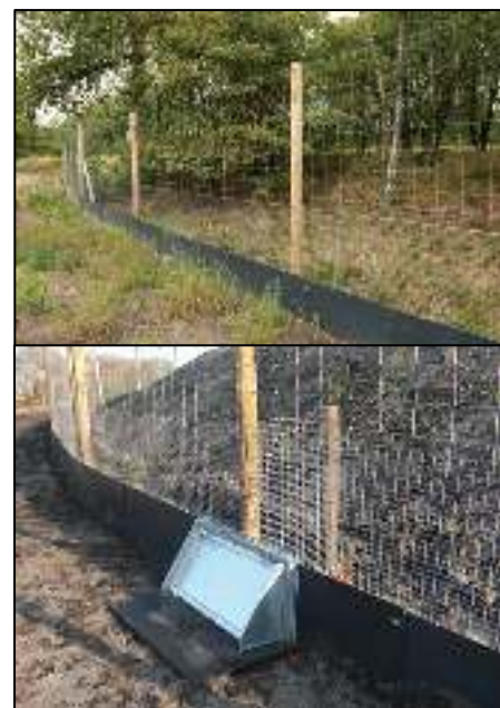
Figuur 2. Boven: Een combiraster met aan de bovenzijde een rood wild raster, in het midden een klein wild raster en aan de onderzijde een kunststoffen amfibieënwand. Onder: een combiraster vergelijkbaar met 'boven' waarbij een sluis als vluchtmogelijkheid is aangebracht. Bron: http://www.arfman.nl/producten/faunatechniek
