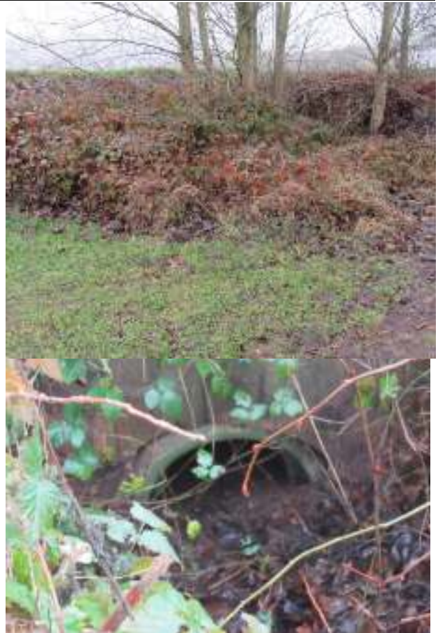
Figuur 35. Boven: Een opslag van snoeiwerkzaamheden voor de ingang van passage 19. Onder: Passage 19 met een dichtslibbende doorgang. Bron: Matthé Wind
