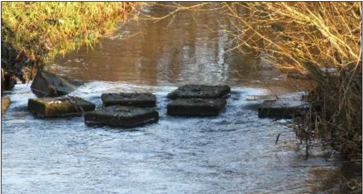
Figuur 71. Een vistrap in de vispassage in de nevengeul van de Schipbeek. Bron: Matthé Wind
