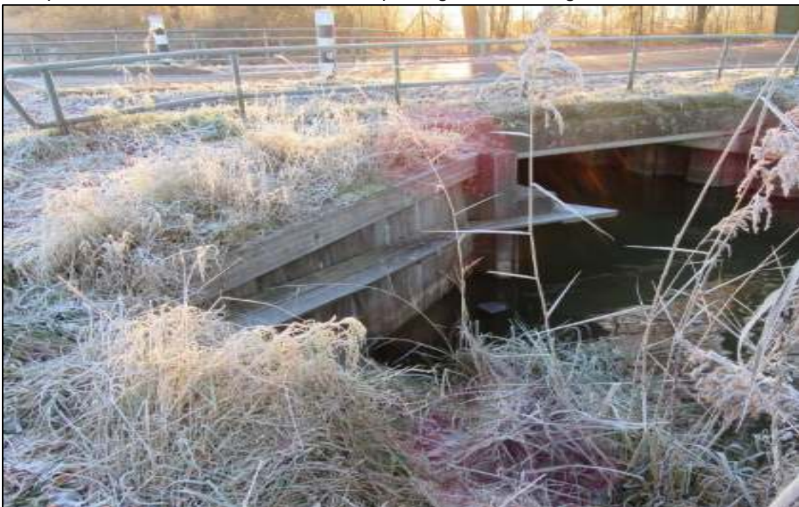
Figuur 50. De loopplank onder de Laan van Borgele - Boxbergerweg van dichtbij. Bron: Matthé Wind
