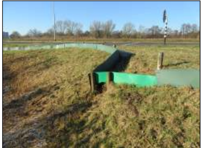
Figuur 13. De amfibieëntunnel met een amfibieën wand als geleiding.
