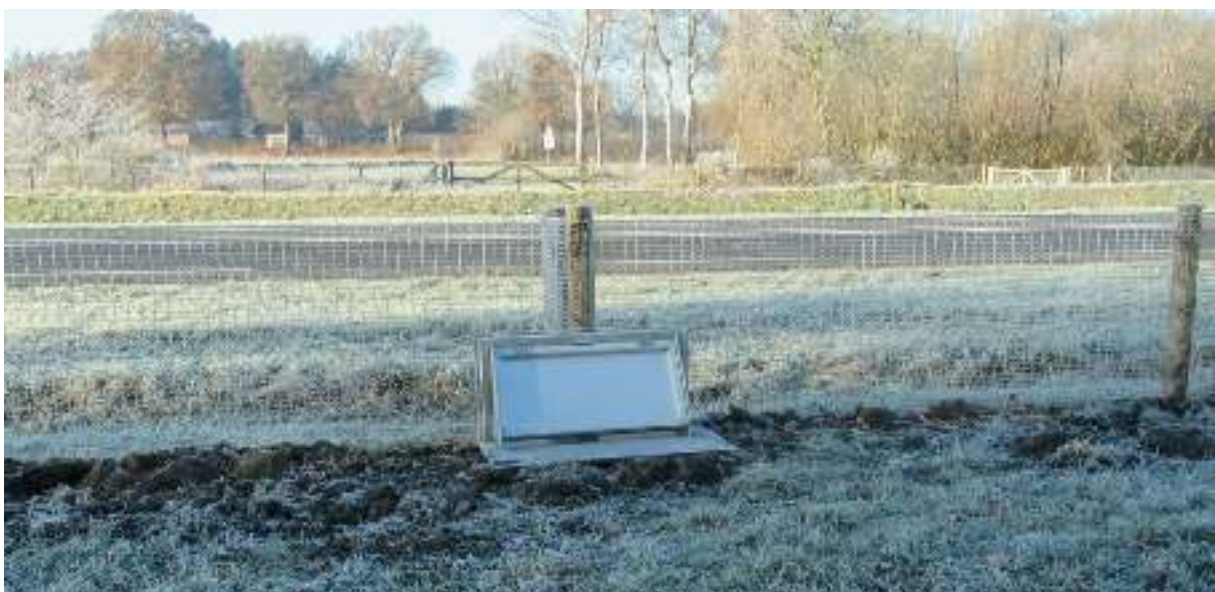
Figuur 33. Een sluis voor klein wild om naar de veilige kant van de geleiding te komen.
