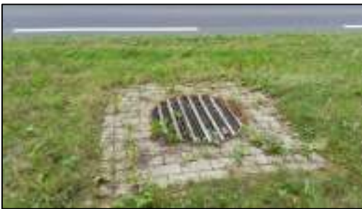
Figuur 5. Een lichtput om lichtinval in de amfibieënpijp te waarborgen zodat amfibieën de pijp in gelokt worden. Bron: Matthé Wind
