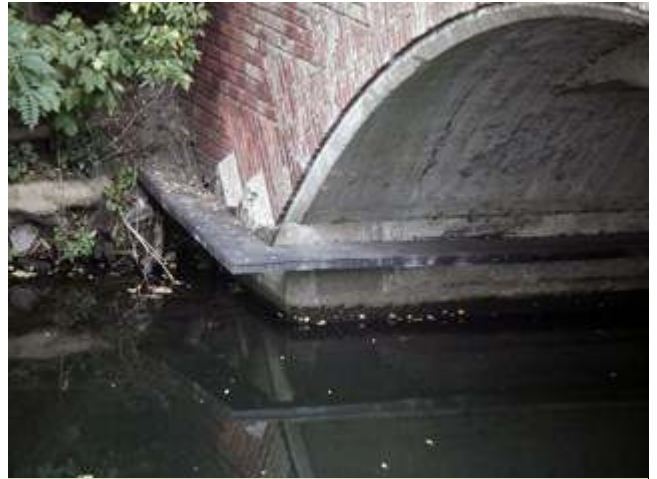
Figuur 7. Loopplank ten behoeve van klein en middelgrote zoogdieren voor het passeren van een oeveronderbreking. Bron: www.utrecht.nl , Fotograaf Jan Lankveld
