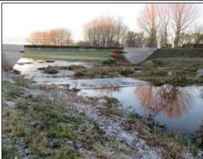
Figuur 67. De vistrap in de Schipbeek in de stad Deventer. Bron: Matthé Wind
