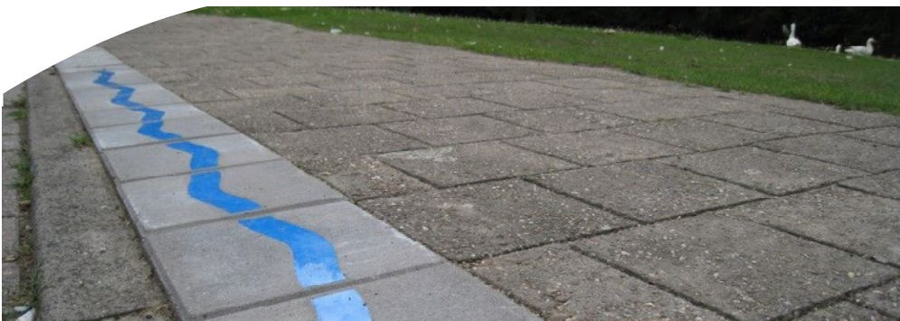
Afbeelding 18: 'Golftegel' wordt toegepast om het trottoir te verlagen op plekken waar regenwater vanaf de weg het groen kan inlopen om daarmee wateroverlast te voorkomen en verdroging van het groen tegen te gaan.
