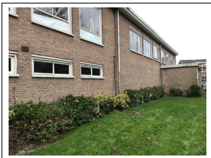
Ontluchtingspunt aan het gebouw van Hetenstraat 57
