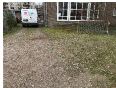
foto 3 - halfverhardingslaag met puin ter plaatse van boring 12
