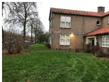
foto 2 - Van Hetenstraat 59 (ter plaatse van boring 08)
