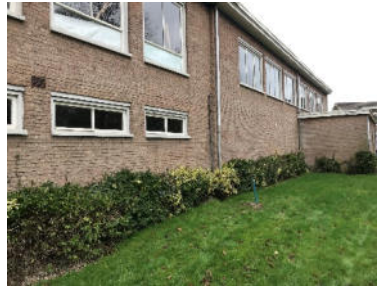
foto 5 - ter plaatse van vml. ondergrondse tank (boring met peilbuis H1)
