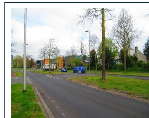
Duurzaam asfalt BAM recycleert in asfalt een voorbeeld uit Deventer o.a. Overstichtlaan
