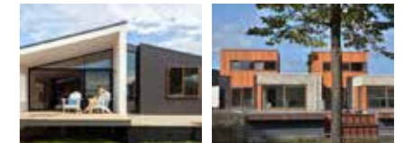
plaatmateriaal en hout houten gevelbekleding en metselw
