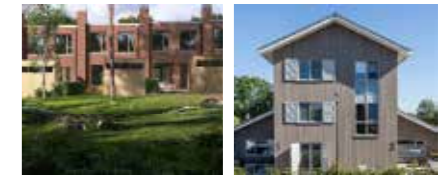
metselwerkgevel houten gevelbekleding
