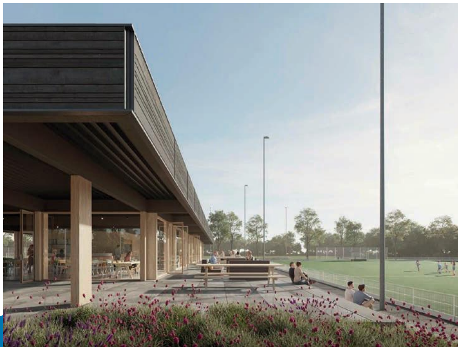
gevelopeningen maken het gebouw transparant naar de aangrenzende buitenruimte
