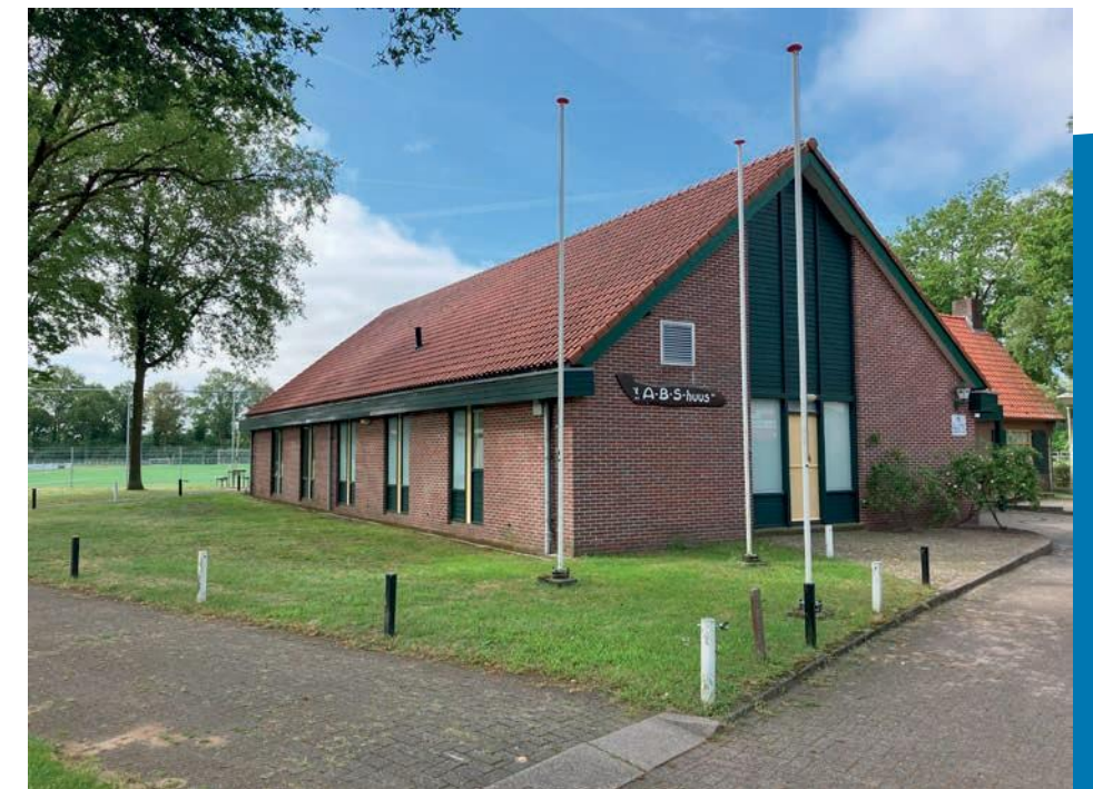
het clubgebouw van ABS en de buitenkleedkamers werden destijds vormgegeven als 'boerderij met loopstal'
