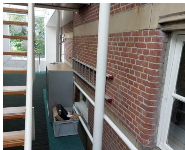
De aanbouw is voor de originele gevel geplaatst.
