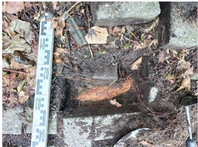
3.5.2 - Figuur 7: Proefsleuf boom 7
