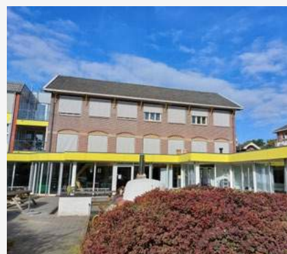
Huidige aanbouw Gymzaal - Kweekschool
