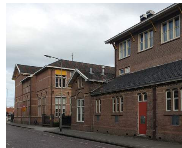
Gymzaal en het entreegebouw.
