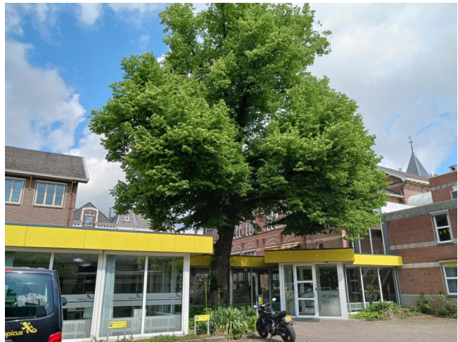
3.5.1 - Figuur 6: Huidige bebouwing rond boom 24
