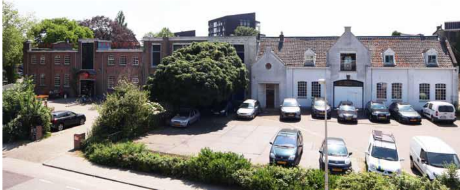
Figuur 5: vooraanzicht van het Zijthoff gebouw. Het linker gedeelte (10b) dateert uit 1916, het rechter gedeelte (10a) is opnieuw opgetrokken na de oorlog.
