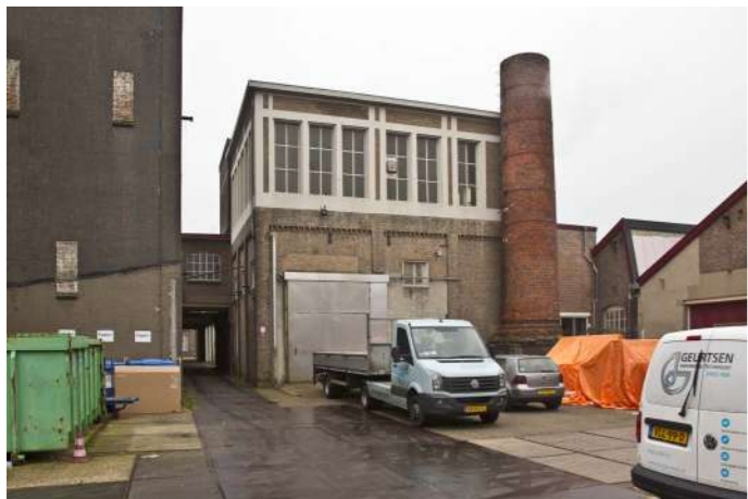
Het ketelhuis als verborgen parel in één van de binnenkamers. Een belangrijk expressief element van het ketelhuis is de (afgeknotte) schoorsteen.
