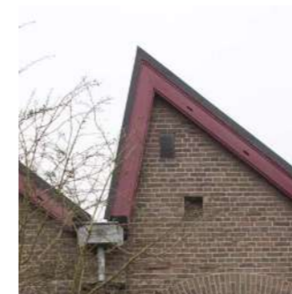
Rood gevelschrijnwerk als dakrand van de productiehallen
