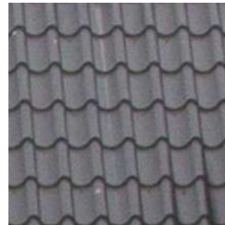
Donkerblauw metaal/kunststof dakpannen, oorspronkelijk keramisch en gesmoord.
