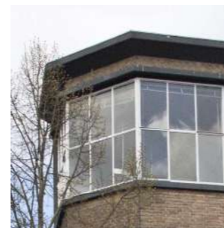
Rechthoekige ramen met stalen kozijnen en een kleine ruitverdeling.
