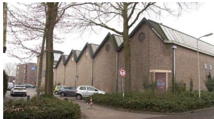
De hoek die gedefinieerd wordt door sheddaken is direct ook de meest gesloten hoek van het ensemble
