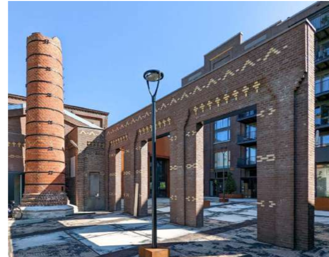
fabriekselementen laten staan
