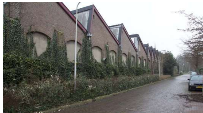
Sheddaken met enkele beuk gaan over in sheddaken met dubbele beuk
