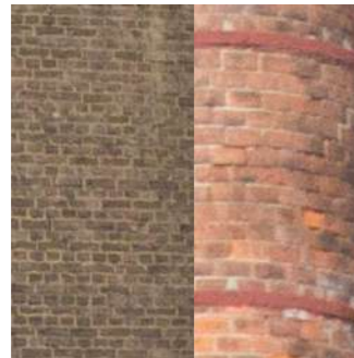
Het ketelhuis is gemaakt van gele baksteen en de schoorsteen van orangerode baksteen.
