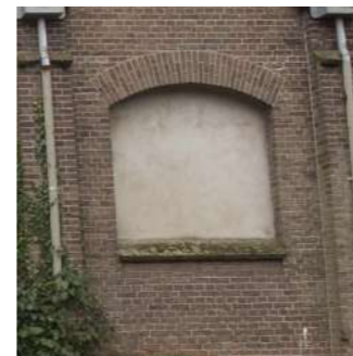
Oorspronkelijk bevatten de productiehallen boogramen.
