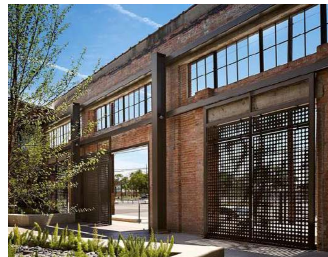
fabriekselementen laten staan
