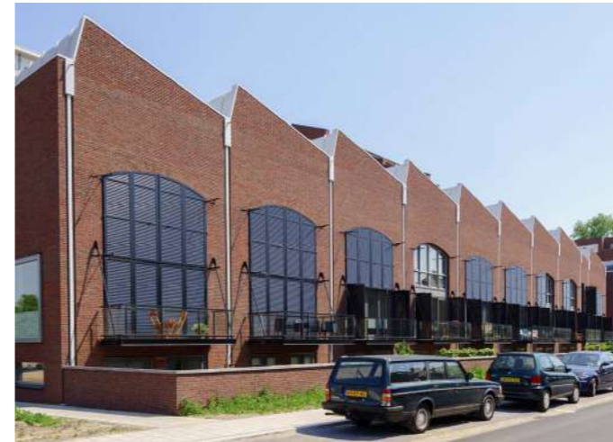
op sheddak geïnspireerde kap en architectuur
