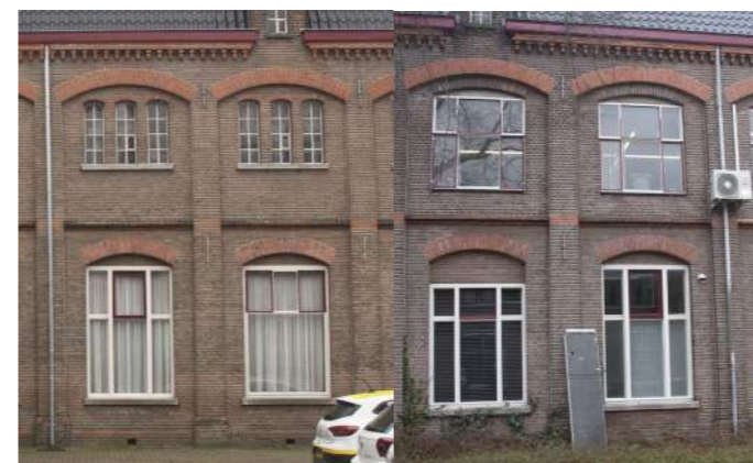
Originele raamopeningen (links) versus aangepaste raamopeningen (rechts)
