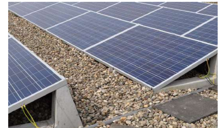
4. Hoogste daken met dakgrind en zonnepanelen
