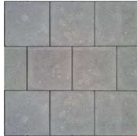
betontegels omliggende straten
