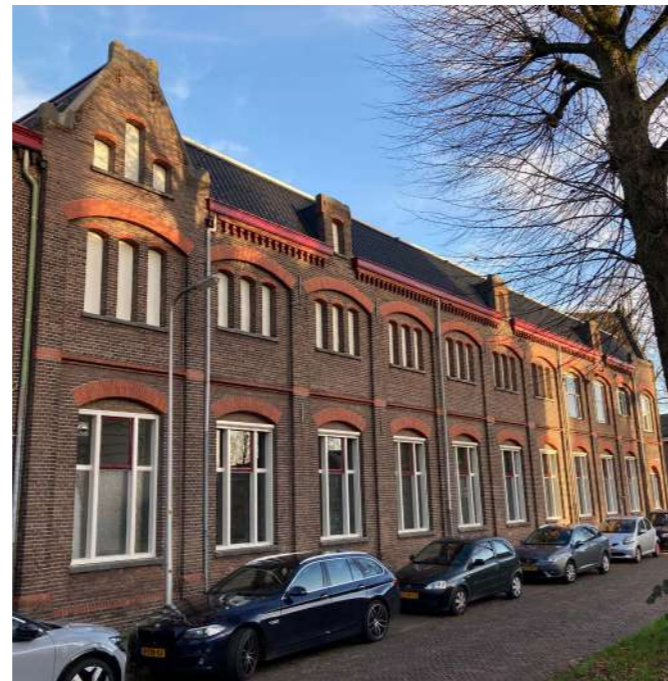
Hoofgebouw aan de Smyrnadwarstraat
