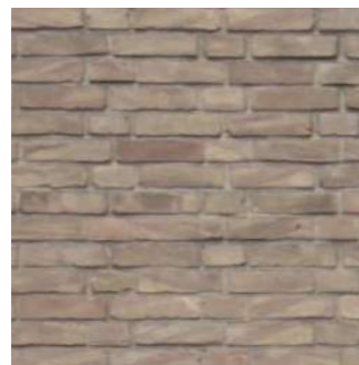
De vrij bijzondere roodachtige baksteen van het labkantoor is geel gevlamd.
