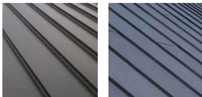
dakbedekking van niet platte daken is donkergrijs of donkerzwart - GEEN bitumen
