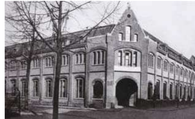
Een oude foto laat de originele raamconfiguratie zien. De poort was vroeger een boogpoort
