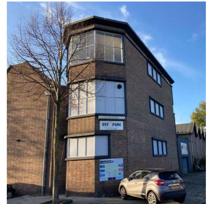
Kantoorgebouwtje aan de Tapijstraat van Postma
