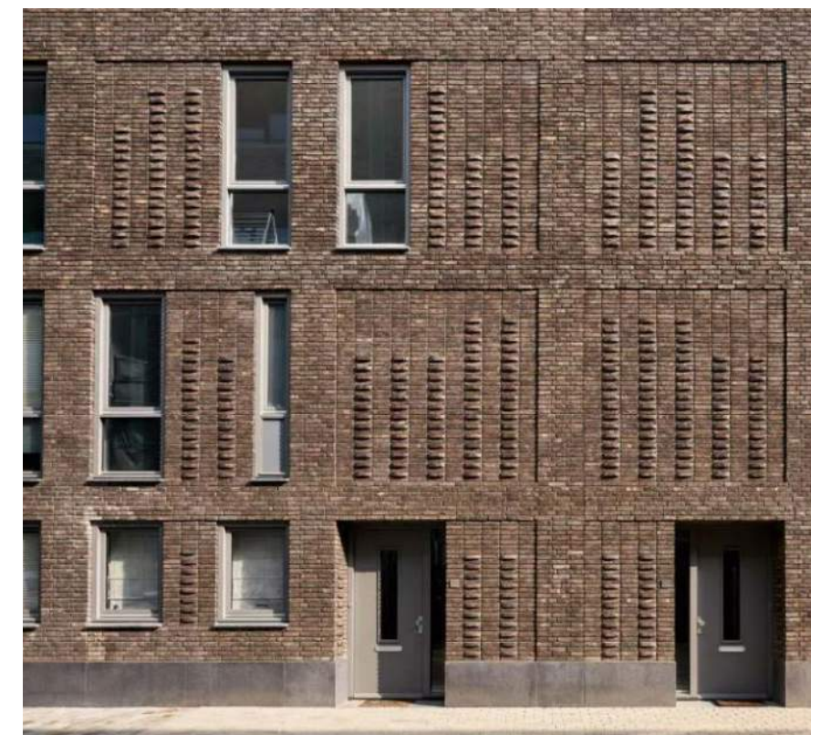
verrijkingen door bijzonder metselwerk
