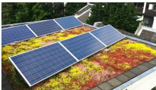
Afbeelding 18 - Sedum en zonnepanelen
