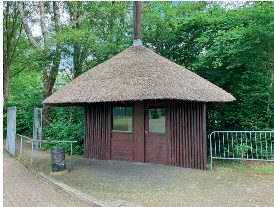
het kassagebouw of de 'hooimijt'
