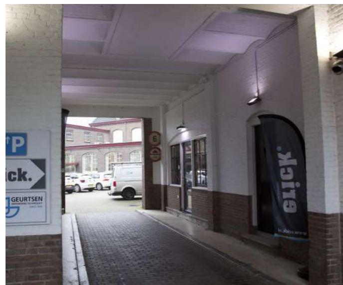
De poort biedt toegang tot de entrees en trappenhuizen van het kantoor
