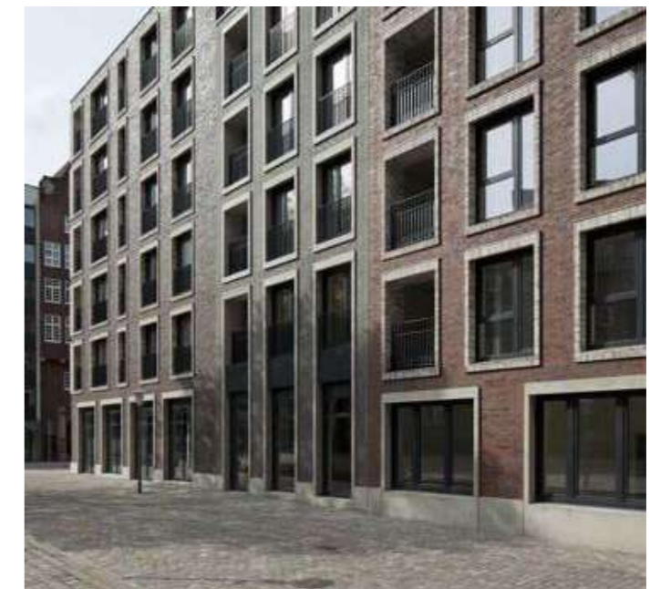
Doorgaande horizontale gebouwsokkel
