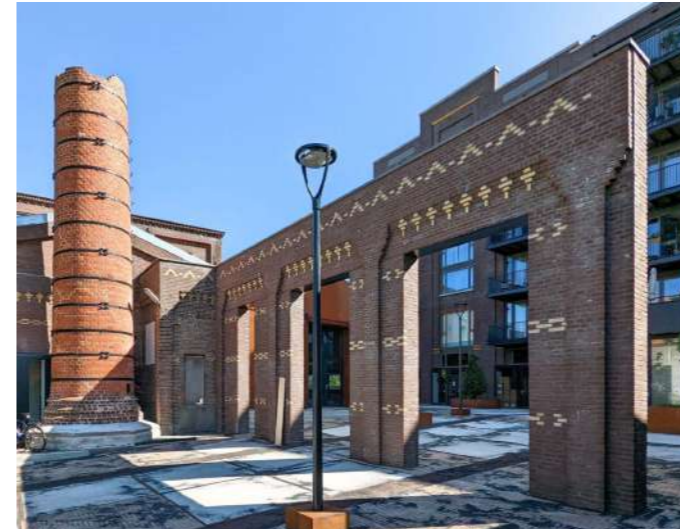
fabriekselementen laten staan
