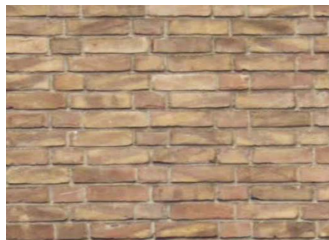
benadering van de rood met geel gevlamde baksteen van het labkantoor na het schoonmaken van de gevel
