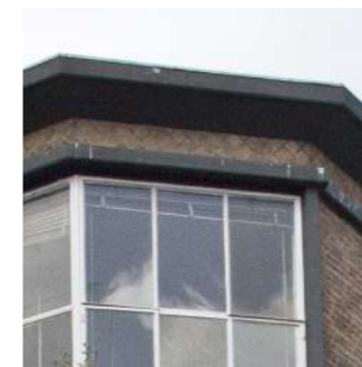
De betonnen kaders en dakbeëindiging zijn grijs (geschilderd).
