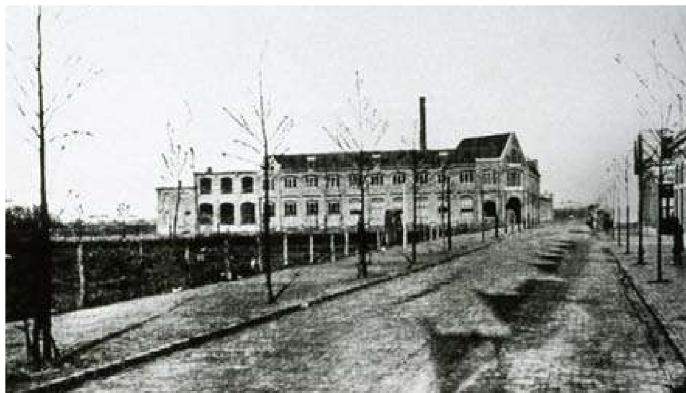
Het kantoorgebouw verscheen als een van de eerste gebouwen in de wijk
