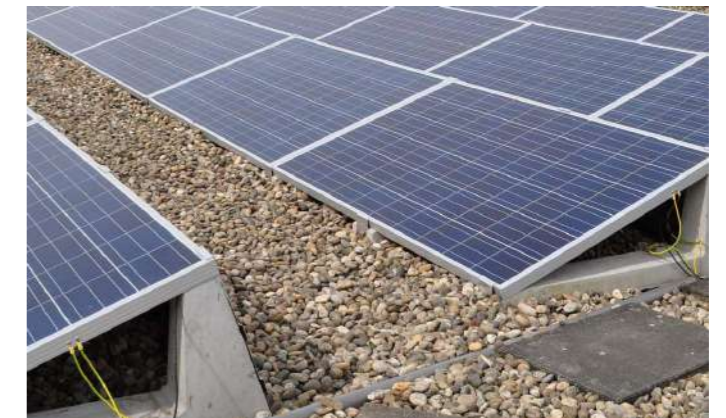
4. Hoogste daken met dakgrind en zonnepanelen
