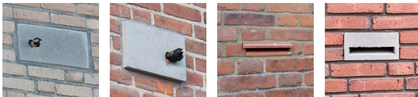
nestkasten en neststenen integreren in gevel
