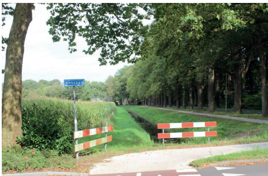
De knik in het fietspad langs de Boxbergerweg wordt door veel omwonenden als onveilig gezien.
