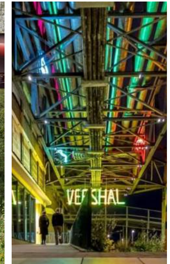
Verlichting gekoppeld aan brug
