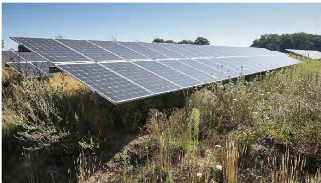
Voorbeeld van een zonnepark met ruimere opzet en op ecologische leest bij Hengelo (Gelderland) op voormalige akkergrond. Met royale tussenruimte voor meer lichtinval en de ontwikkeling van bloemrijk grasland en daarmee voorkoming van bodemverslechtering. Het gevoerde beheer hier is roulerende schapenbegrazing. Foto: EcoNatura.
