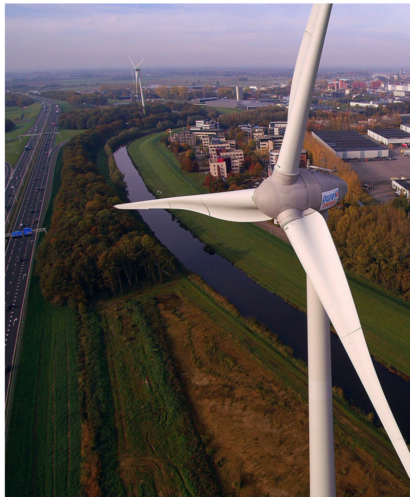
Windenergie langs de A1 bij Deventer
